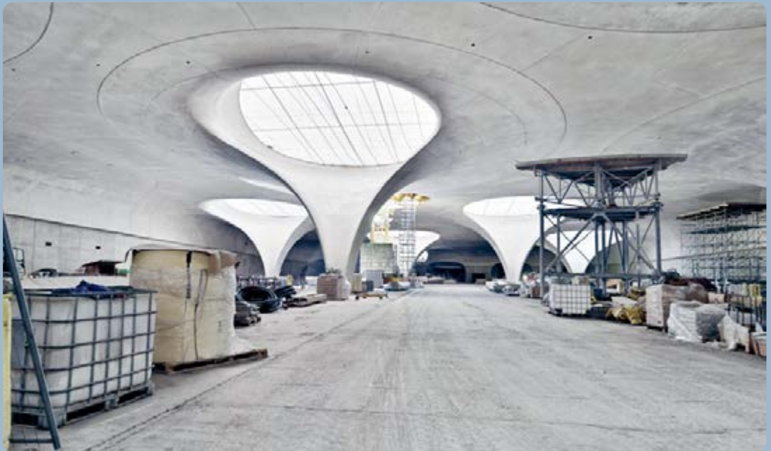
Durch die sich nach oben öffnende Form leiten die Kelchstützen das Tageslicht direkt von außen in die Bahnsteighalle des neuen Stuttgarter Durchgangsbahnhofs. Aufnahme von Arnim Kilgus, Juli 2022
